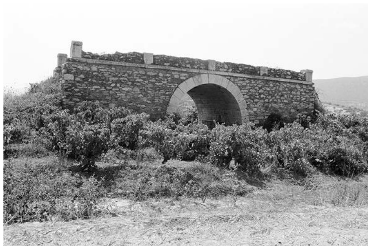
Figure 17 : vue du pont désaffecté enjambant un canal d'évacuation des eaux dans le même secteur du plateau de Vélousia - Koutoumoula (photo D. K. 2002).
