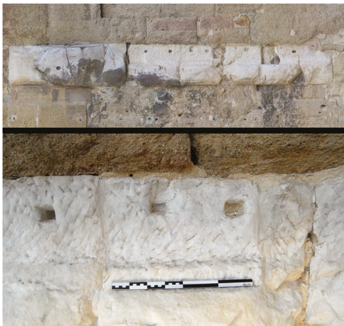
Figure 14 : corniches retaillées du premier ordre du retour latéral ouest avec mortaises rectangulaires près de l'arête supérieure. En haut, ortho-images, M. Seguin (SRA Corse), en bas, cliché T. Bartette.
