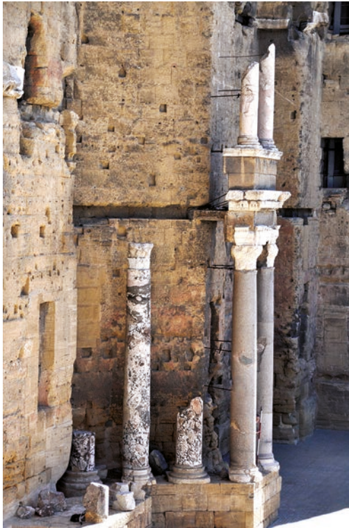
Figure 3 : restauration des ordres latéraux (cliché IRAA).
