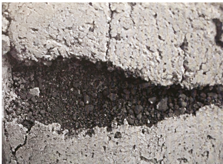
Figure 6 : aperçu de la couche de pouzzolane entre deux banchées de mortier, villa des Quintili, Rome [C. GIORGI, L. FESTA, A. LUGARI, « La tecnica esecutiva dei rivestimenti parietali marmorei (incrustationes) : studio e sperimentazione », Atti del XVI colloquio dell'Associazione Italiana per lo Studio e la Conservazione del Mosaico (Palermo, 17-19 marzo 2010 – Piazza Armerina, 20 marzo 2010), Tivoli 2011, fig. 3].
