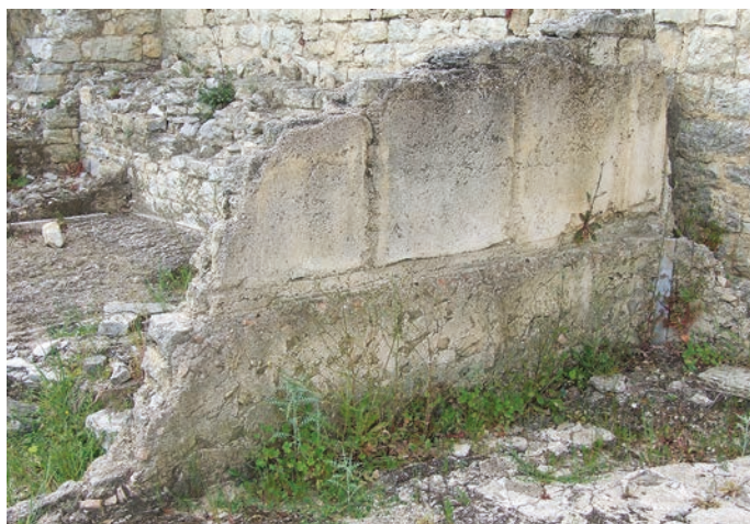
Figure 9 : pièce 2 du complexe monumental, Murviel-lès-Montpellier (cliché A. Bouet).
