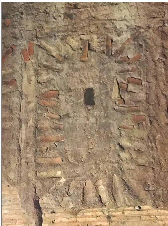
Figure 4 : disposition radiale des cales sur une paroi de la Domus Aurea , Rome (cliché. L. Barataud).
