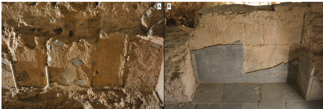
Figure 14 : bassin en T (A) et bassin central du frigidarium (B) des thermes de Jublains (cliché. L. Barataud).
