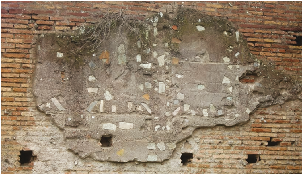
Figure 3 : cales et mortier sur une paroi de la maison des Vestales, forum Romain, Rome (cliché. L. Barataud).
